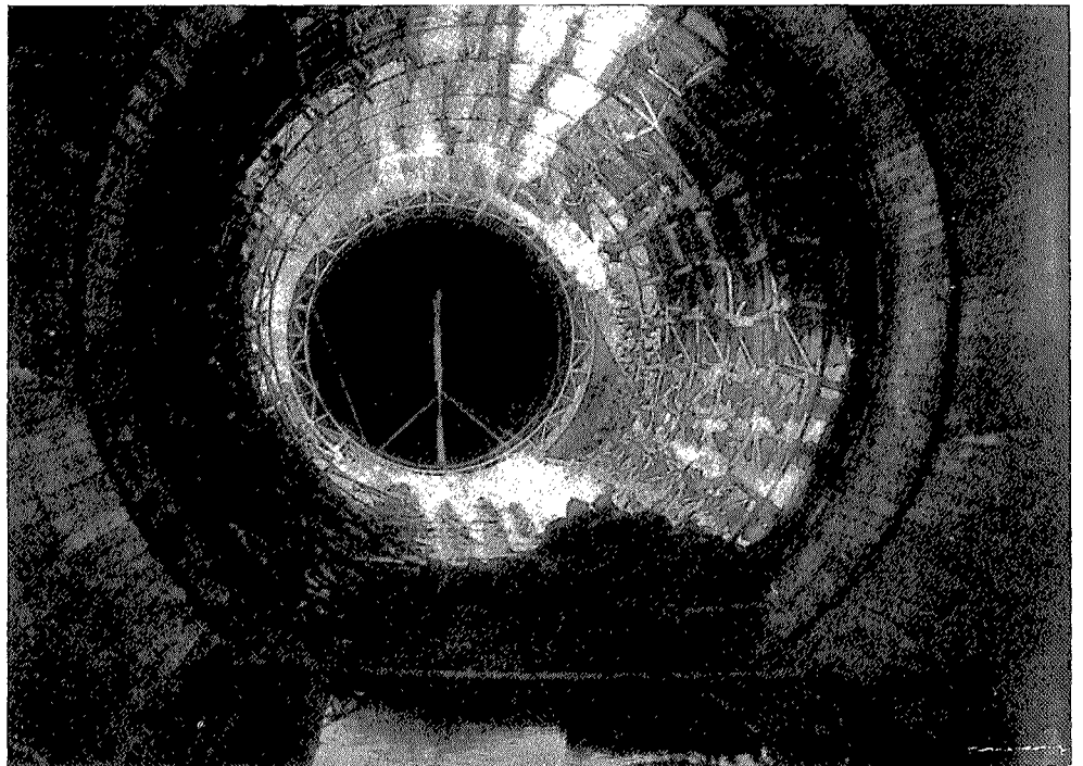
Fig. 6. a — Vista desde aguas abajo durante la ejecución de las obras. Sketch No. 6. — Upstream view, during the construction.
