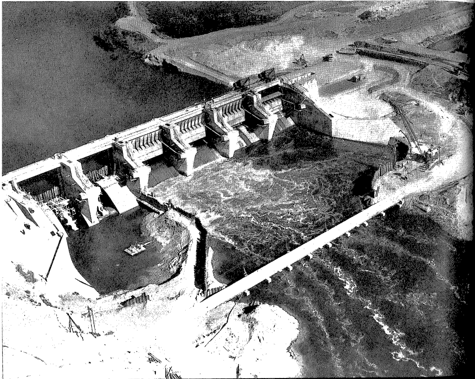
Fig. 4. a — Presa de Castrejón. Achique del recinto 3.
