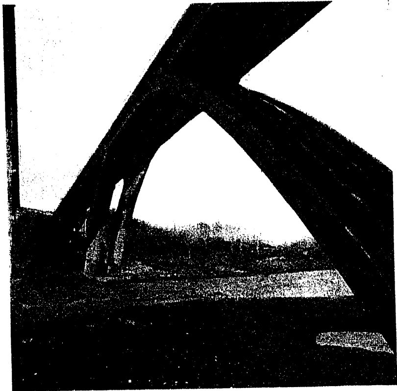
Puente sobre el Arno, en Bradano. Luz 111 m. S. ZORZI.
