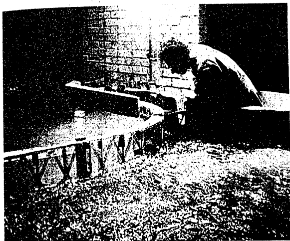
La presa en el Rin, cerca de Hagestein: Ensayos modelo con una compuerta tipo visera.
