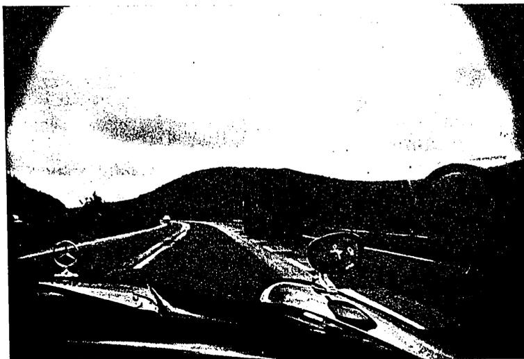
Fig. 3.<sup>a</sup> — La tercera vía para tráfico pesado en carreteras de dos circulaciones.
