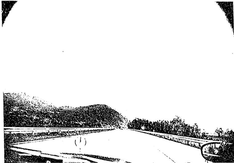
Fig. 5.<sup>a</sup> — Autopista alemana con firme de hormigón hidráulico; en cada vía doble, valla metálica baja.
