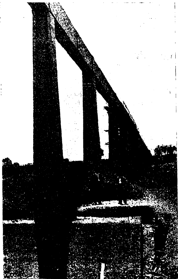
Canales del Guadalcacín (Cádiz). Acueducto de la Canaleja (González Quijano).
