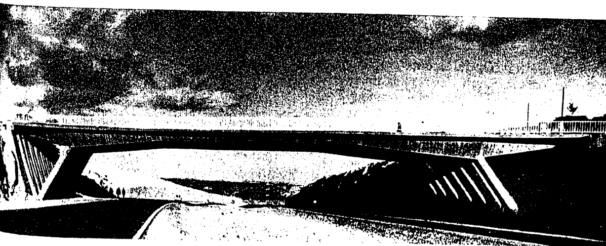
Puente de Galapagar. 48 m.
