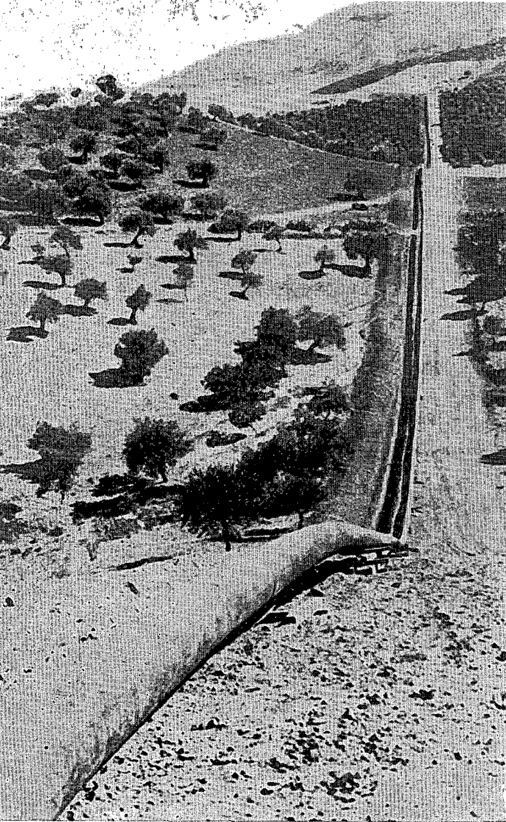
Fig. 11. — Tubería antes del tendido.
