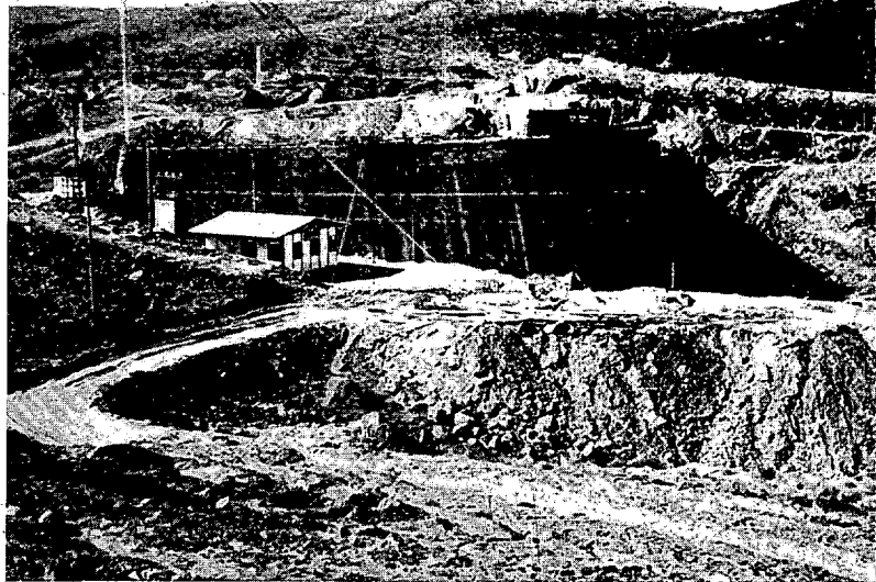
Fig. 11. — Vista general de la obra desde aguas arriba el 22-2-67.
