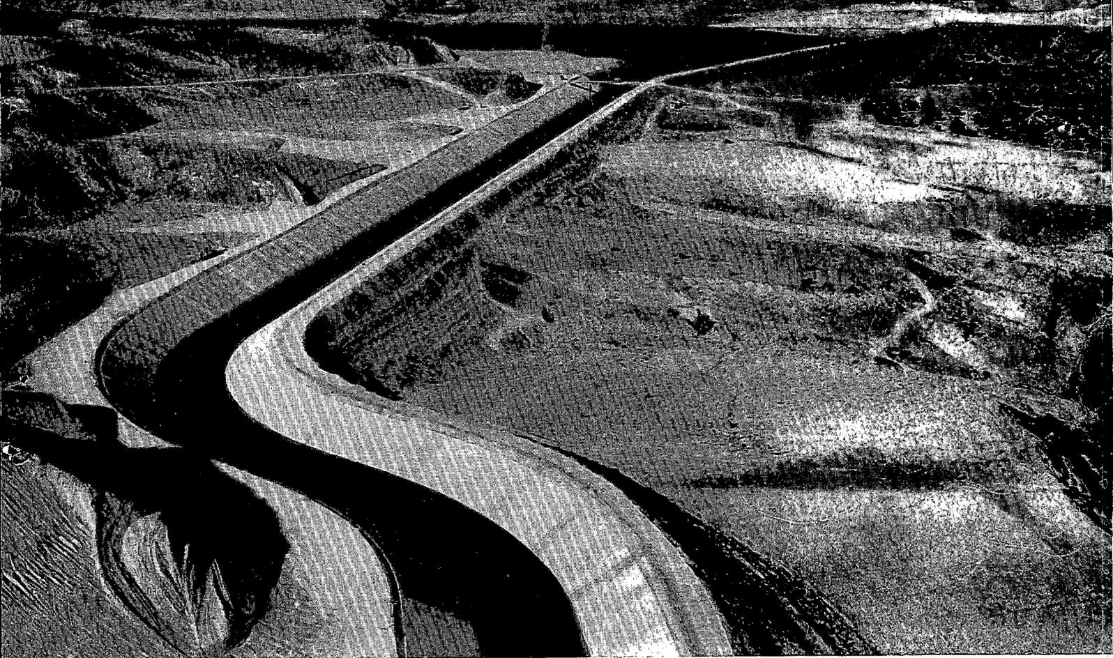
Foto 2.— Presa de El Carpio y tramo de canal revestido de hormigón.
