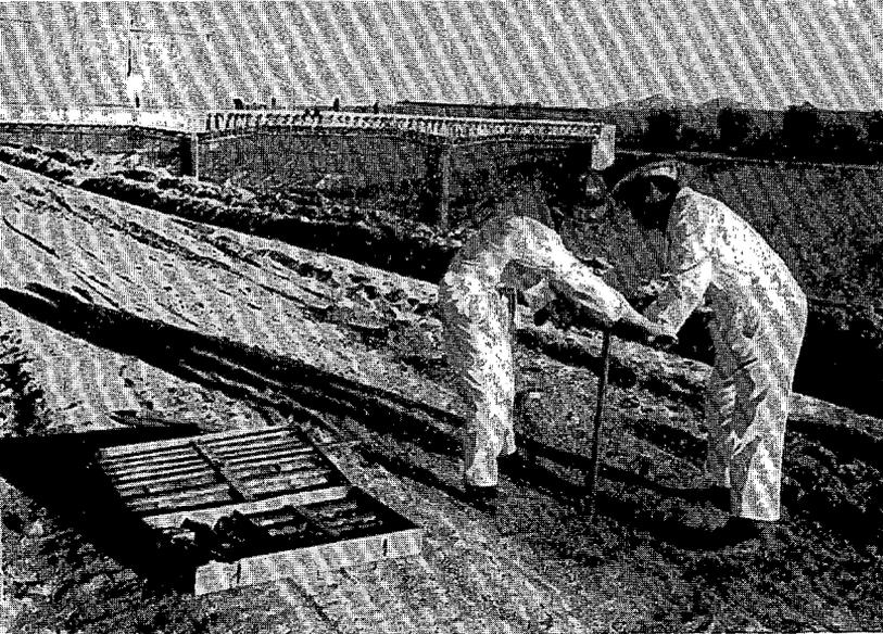
Foto 3. — Obtención de muestra profunda por sondeo manual.
