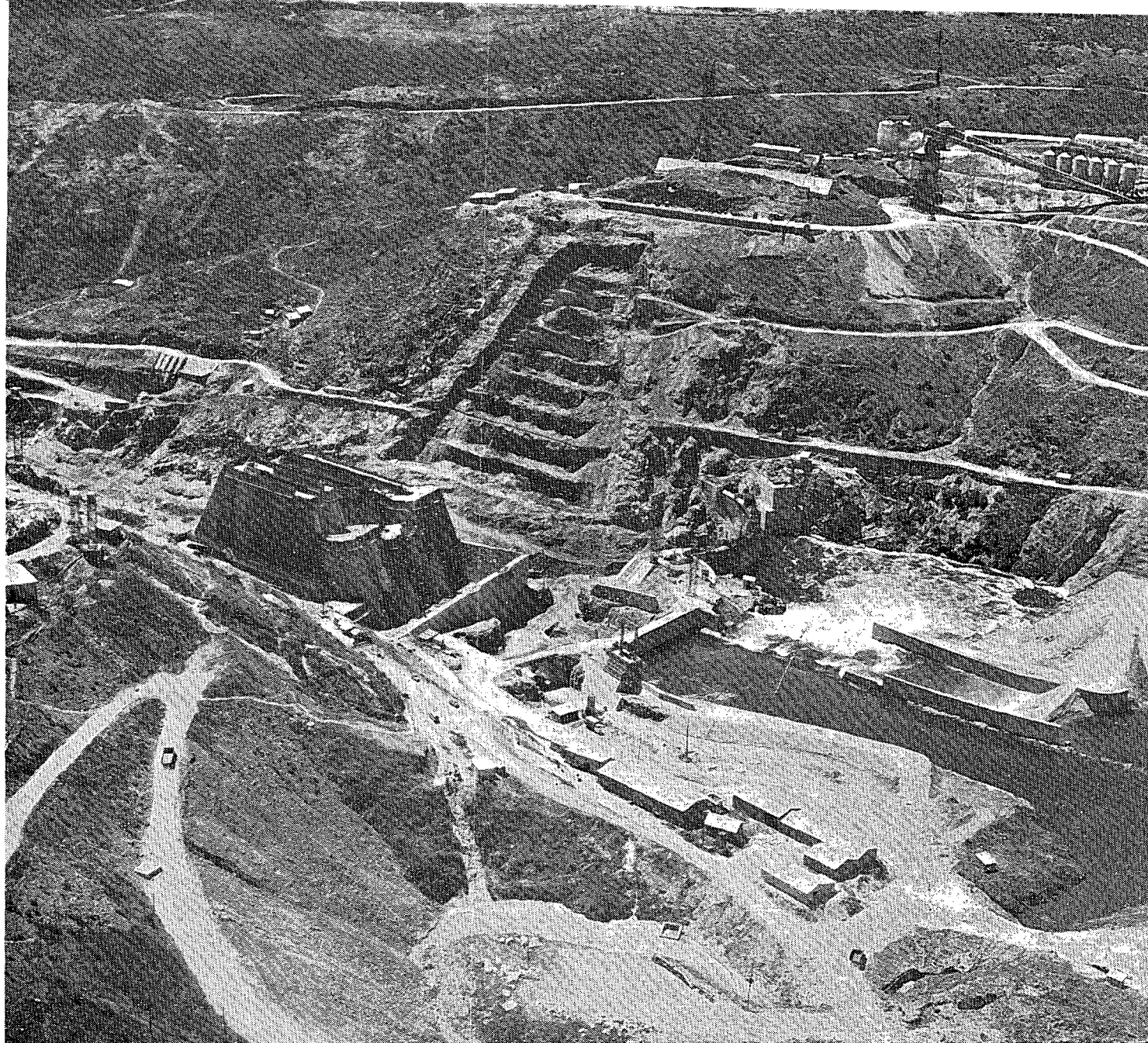
Foto 7.— Excavación estribo derecho. (Right abutment excavation).
