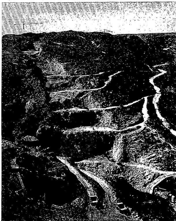
Fig. 1.ª — Vista de la excavación en estribo derecho. (View of the right abutment excavation.)
