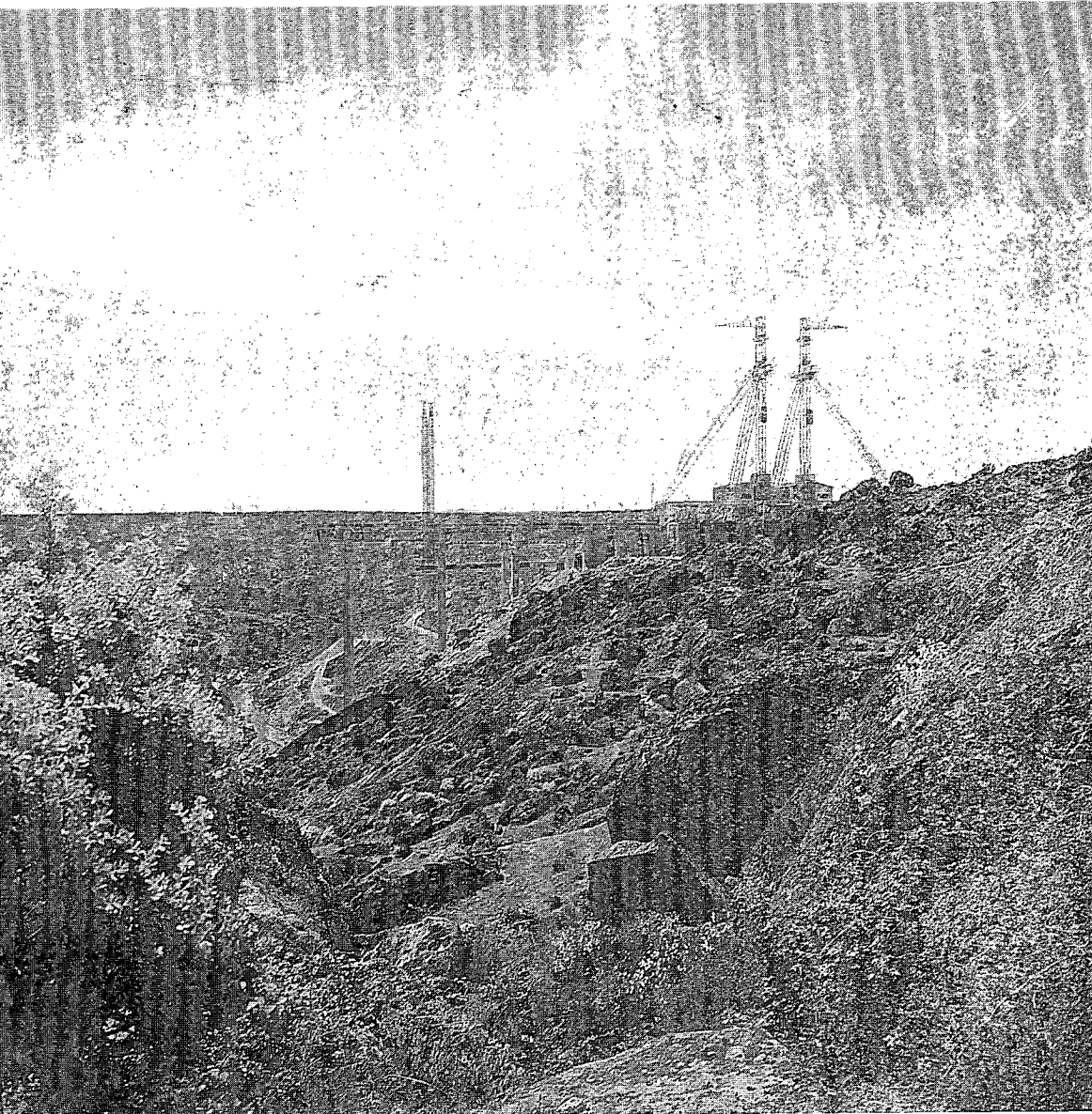
Fig. 11.— Blondines de la presa de Almendra. Torres móviles asimétricas.
