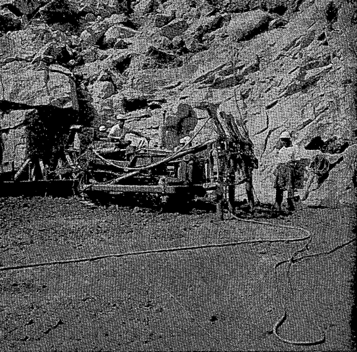
Fig. 9.ª — Vibrado mecánico del hormigón en la presa de Almendra. (Concrete mechanical vibration in Almendra Dam.)
