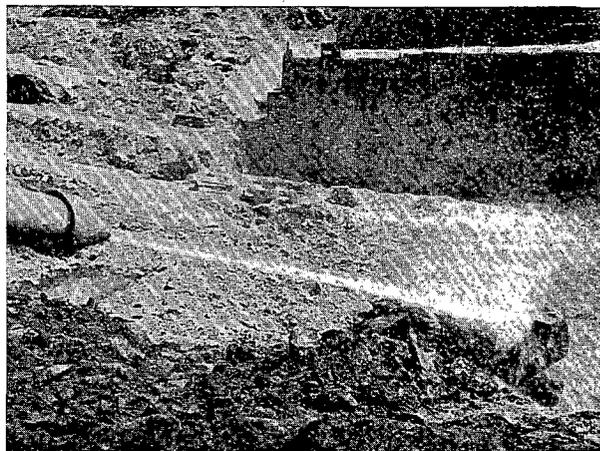
Fig. 2.<sup>a</sup>—Monitor trabajando en limpieza de cimentación de presa. En la fotografía de la derecha puede apreciarse una piedra de gran tamaño removida y arrancada por el chorro de agua.
