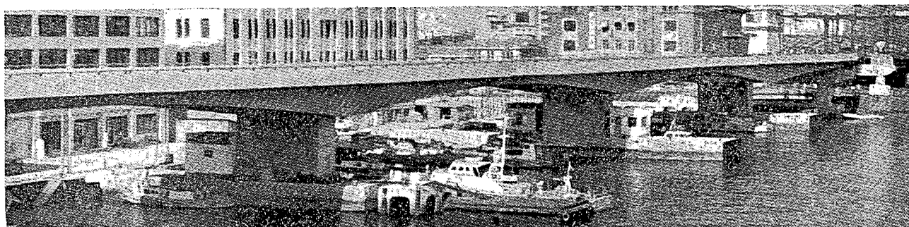
Puente Kyobashi-Nishi (Japón), 70 m.
