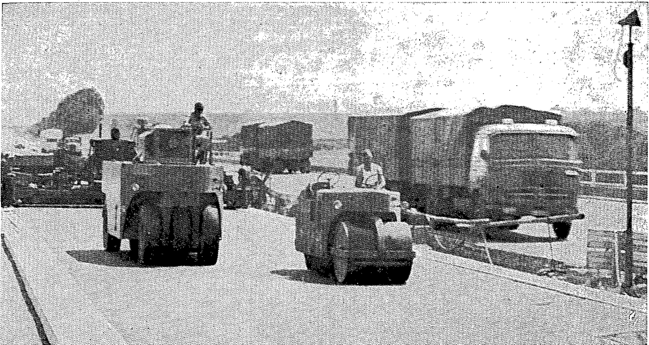
Fig. 2.ª — Empleo de un rodillo de neumáticos y otro vibratorio en la compactación de la capa de rodadura de una autopista alemana.
