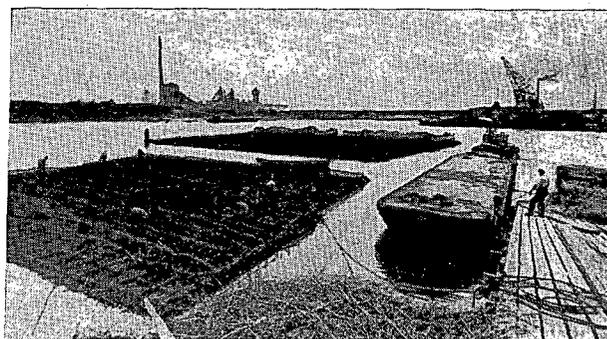
Fig. 1.<sup>a</sup> — Para evitar la erosión por la corriente del fondo, a ambos lados de los espigones se colocó primeramente un revestimiento de colchones de fajinas de 30 x 45 metros. Estas fajinas, que consisten en dos capas de ramas de sauce mimbrero y una capa de caña, fueron remolcadas flotando y sumergidas en plena mar, aumentando su pesantez con canto rodado.
