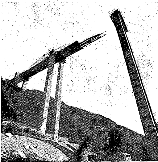
Diversas vistas del lanzamiento integral del tramo.
