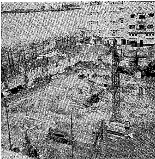
Vista del ángulo NW de la obra durante su excavación. Se aprecia la pantalla perimetral terminada, y al fondo de la excavación, las cabezas de los primeros pilotes.
