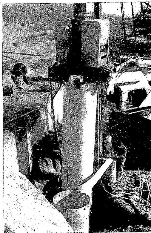
Foto 2-4. — Pilotes entubados por el sistema de vibrohincador.
