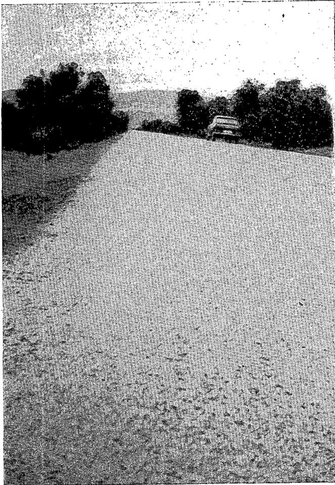
Fig. 3. — Tratamiento superficial en una carretera secundaria. La cobertura total del árido da lugar a una capa más resistente, menos deslizante y con mejor visibilidad nocturna.
