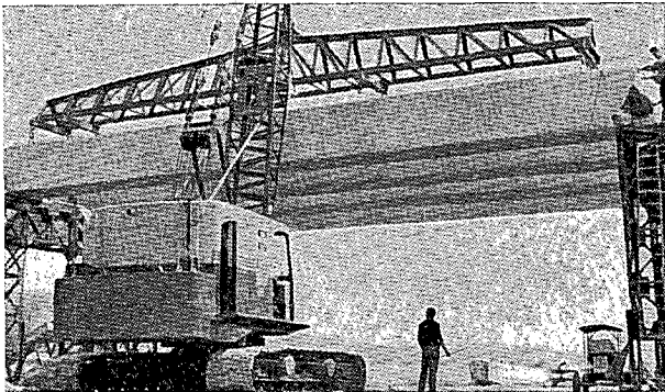
Montaje de elementos de viga.
