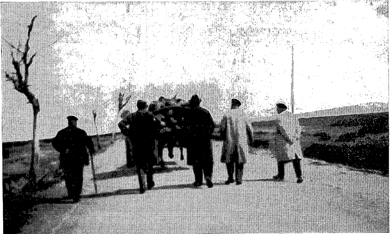
Fig. 4. — Control de calidad en los años 30. El Ingeniero Jefe, subalternos y contratista siguen un carro cargado, a lo largo de todo el trozo de macadam que se recibe, para comprobar que las llantas no dejan huella.
