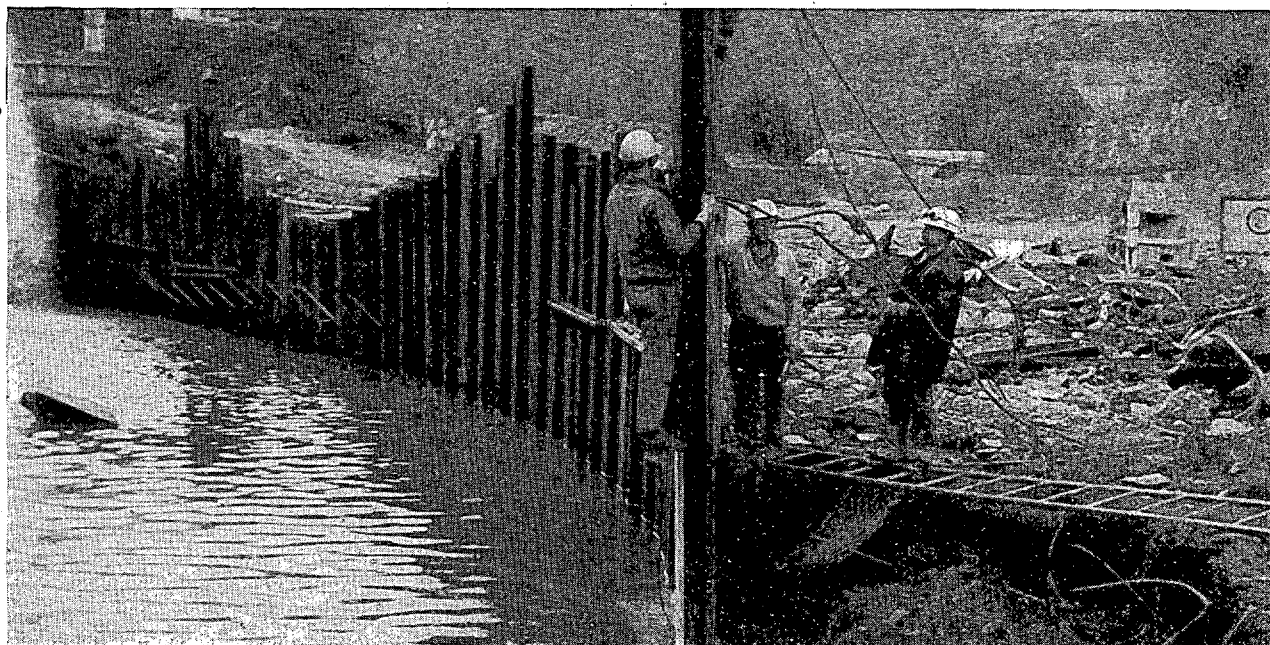
Foto 2.—Ataguía para ejecución de la central de Salto de Arbón.
