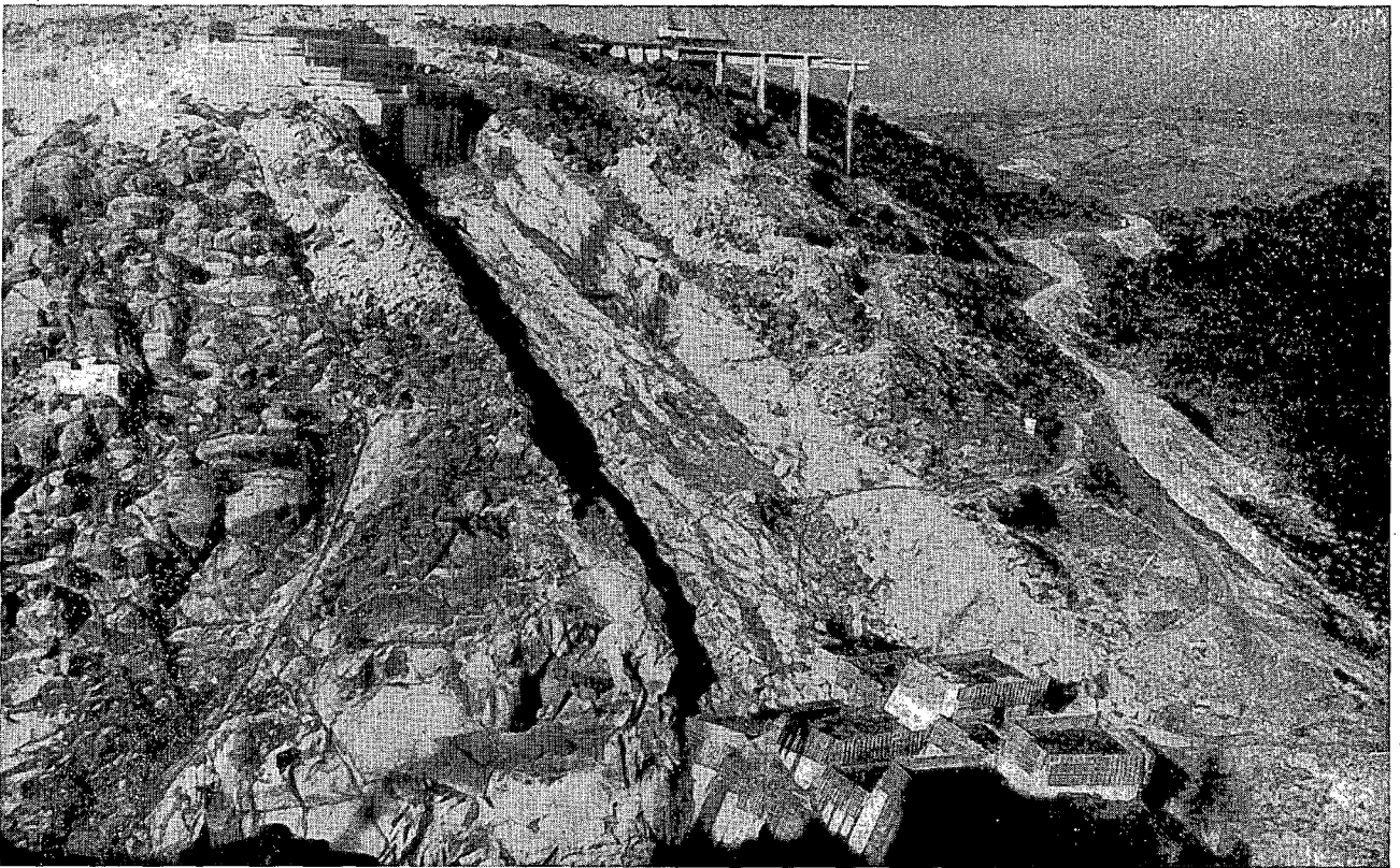
Fig. 9. — Vista general de la margen derecha de la presa de Almendra. Fotografía hecha en diciembre de 1967, mostrando la excavación, los bloques del estribo y los bloques de la bóveda en el cauce.
