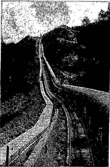
Fig. 9. — Presa de Ibón de Ip. Tubería forzada. (Ibón de Ip Dam. Penstock.)
