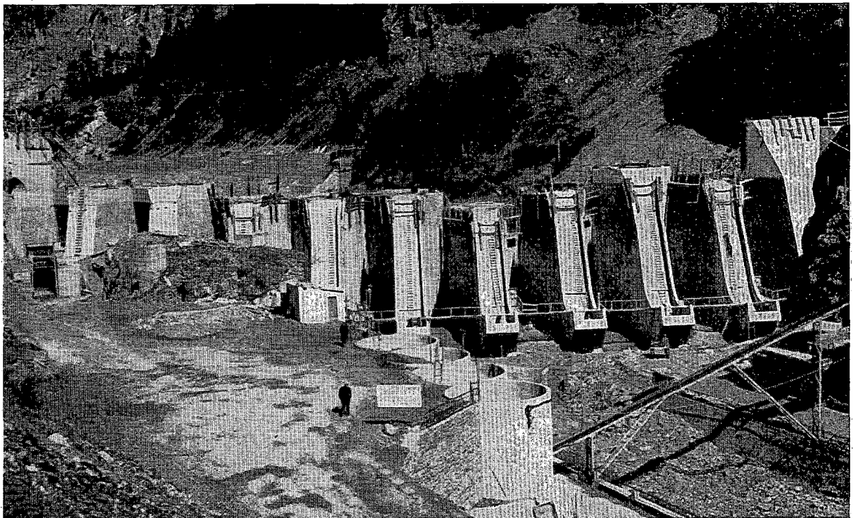
Fig. 12. — Embalse inferior. Vista general de la presa. (Lower reservoir. General view of the dam.)
