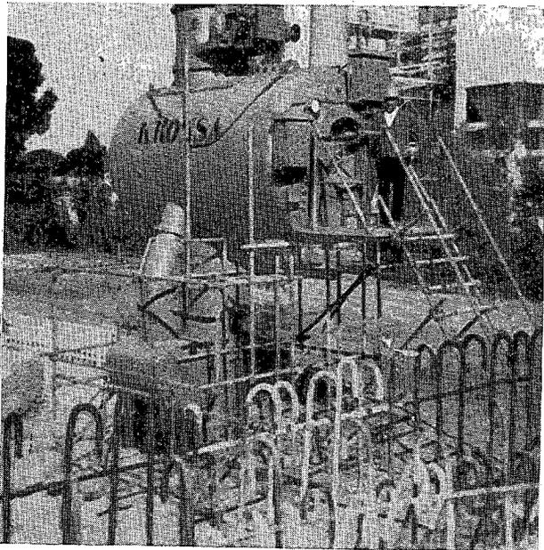
Foto 7.—Hinca de cajones de aire comprimido. Central térmica de Huelva.
