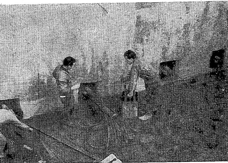
Foto 1.— Refuerzo del cajón agrietado por efecto de la socavación producida por la hinca de otro cajón antiguo.
