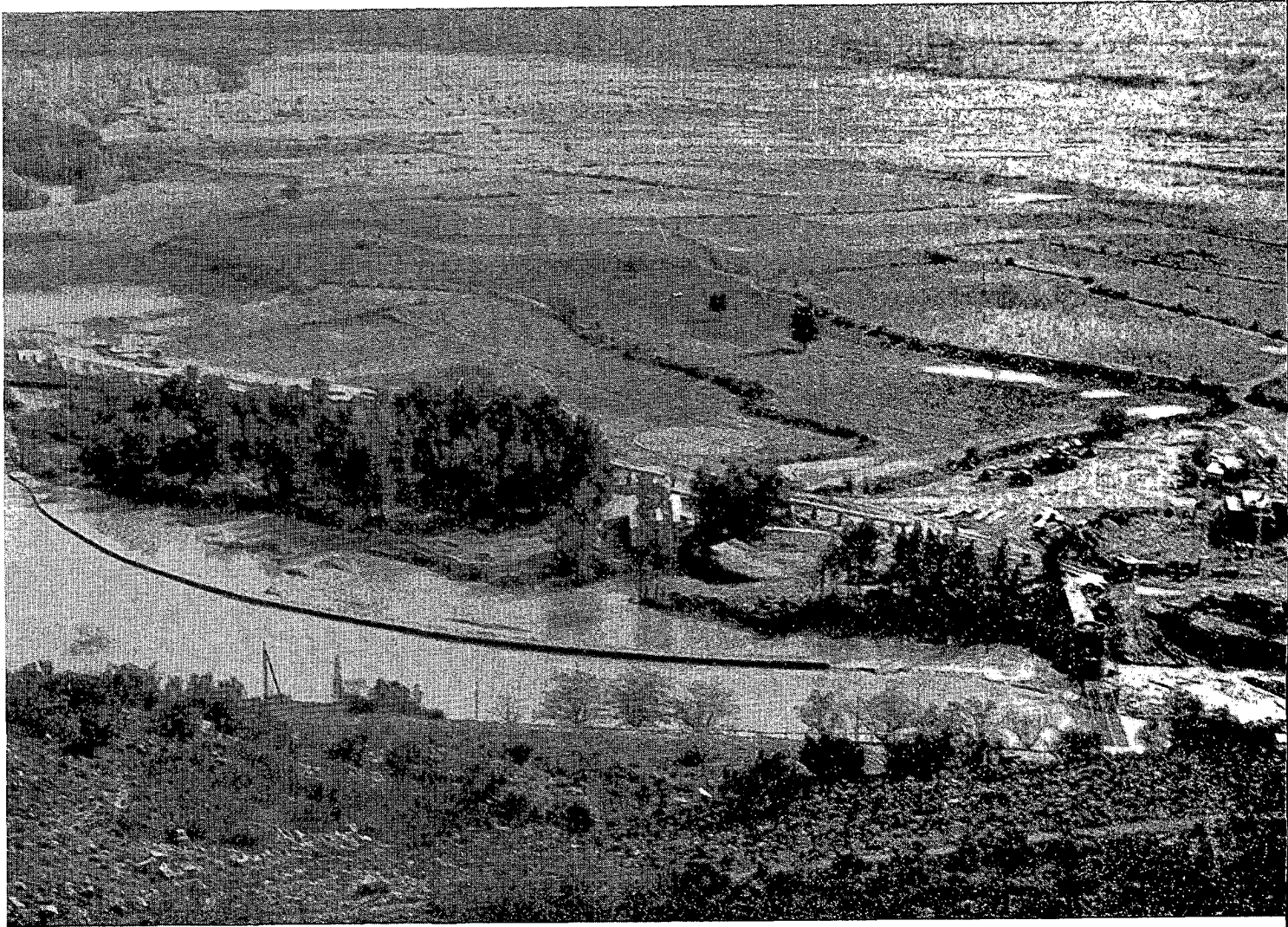
Foto núm. 5. — Defensa de gaviones pilotada en el río Jarama. Fase de construcción.
