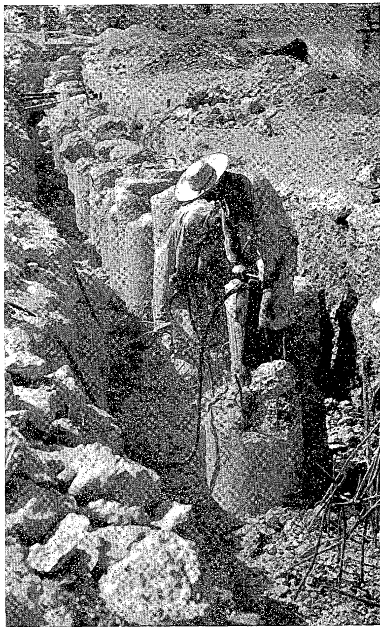
Foto núm. 3.— Defensa del cauce del río Guadalquivir con pilotes tangentes a tresbolillo. Fase de descabezado de pilotes.
