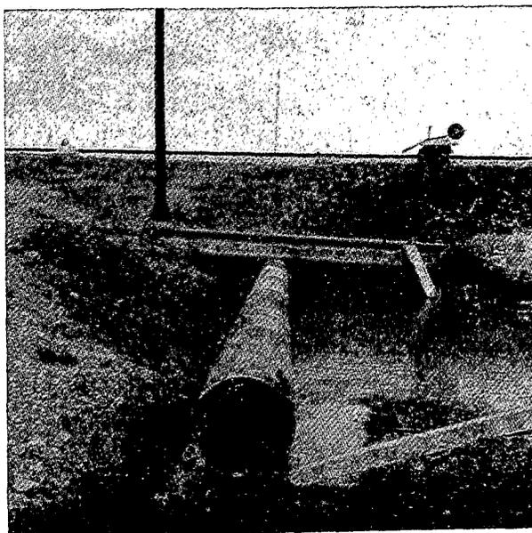
Foto 3.—Aspecto de la tubería de revestimiento al ser arrastrada por la cabeza de perforación. No aparece detritus, ya que se extraen por el lado de la máquina.
