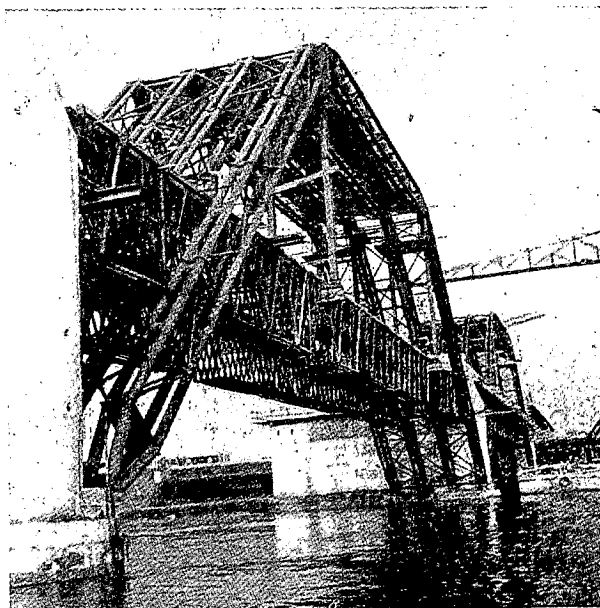
Cimbra del puente sobre el Po en Rodrigo, para la autostrada Bolonia-Padua.
