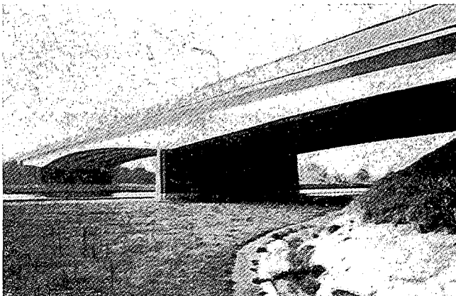
PUENTE MASSEHOVEN SOBRE EL CANAL ALBERTO
