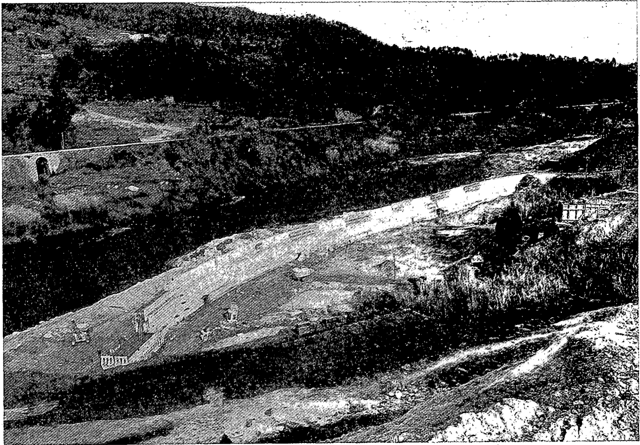
Atagüa construida para realizar la excavación y el hormigonado de la central de Frieira.
