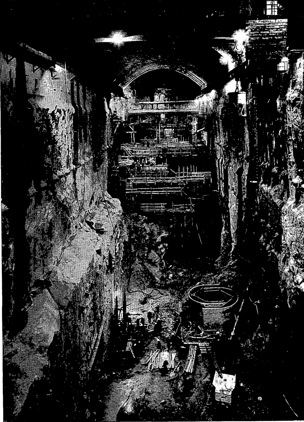
Vista de la caverna de la central al final de las excavaciones.
