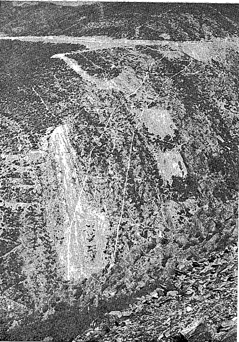
Foto 3.—Ladera izquierda con la presa replanteada en superficie.
