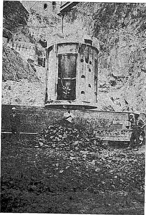
Fig. 16. — Vaciado de un cubo de blondín de 3 m 3 de hormigón (consolidado).
