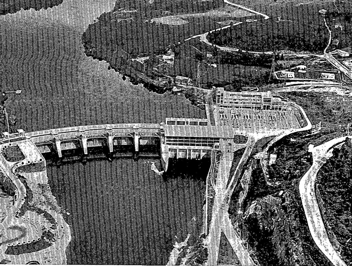
Fig. 9.—PRESA Y CENTRAL DE VELLE, perteneciente a Fenosa. Altura de la presa: 26 m. Longitud de coronación: 195 m. Número de compuertas: cinco de 25 × 10 m.
