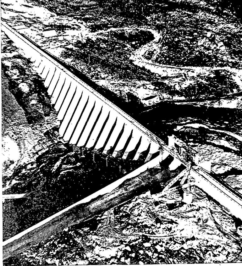
Fig. 3.—PRESA DE SALAS, de contrafuertes, perteneciente a Fenosa. Altura de la presa: 50 m. Longitud de coronación: 1.005 m.
