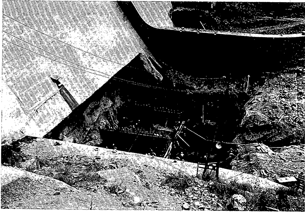
Figs. 8 y 9.— Presa del Sancho. Obra de recalce al pie del aliviadero.
