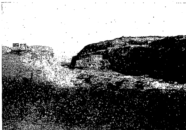
Fig. 3. — Explanación de una carretera en terreno rocoso.
