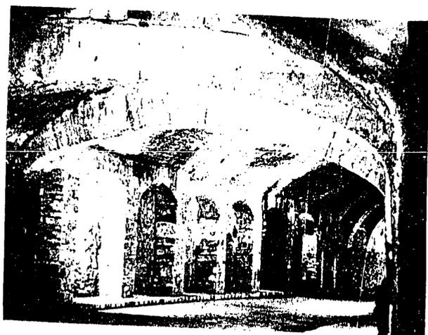
Fig. 1. — Calle subterránea de Guanajuato, México. a) Muros de contrafuertes y bóvedas. b) Parte semidescubierta con viviendas sobre muros y techos del subterráneo.
