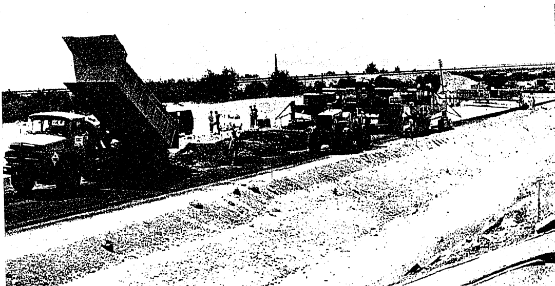
Las extendedoras de gran rendimiento han permitido reducir los plazos de ejecución respecto a los fijados en el contrato.
