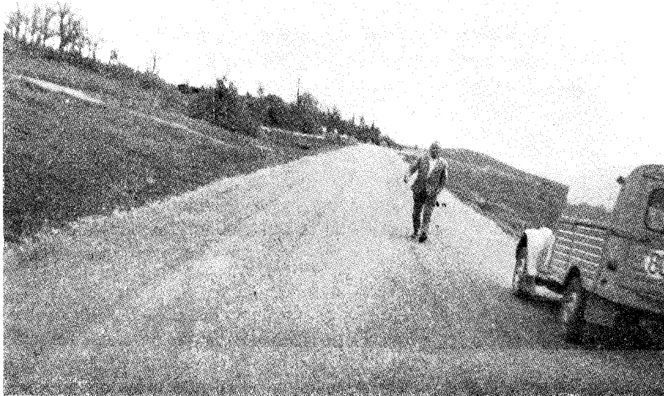
Carretera local en la que el transformado firme de macadam fue cubierto con un doble tratamiento superficial hasta las aristas exteriores de los arcenes. Se tiene así una plataforma totalmente pavimentada.
