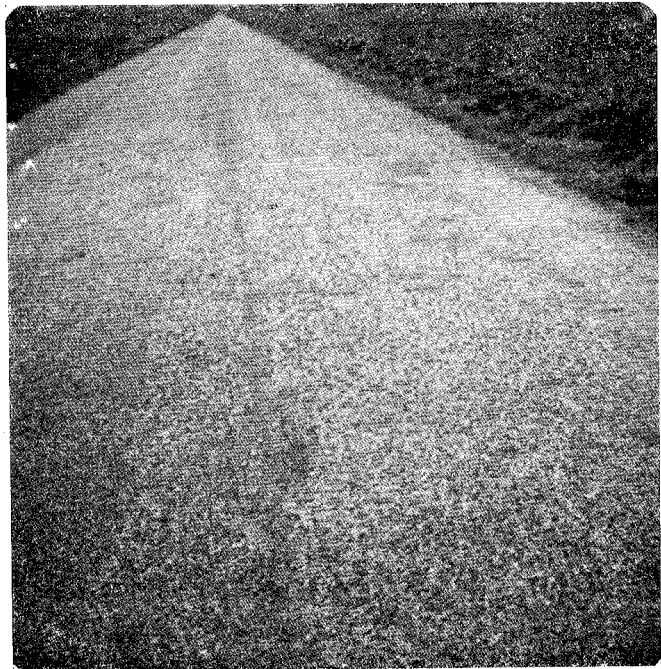
Tratamiento de conservación con árido 8/12 mm, a razón de 16 l/m 2 y 2 Kg/m 2 de betún fluido RC-3, o sea, 1,46 Kg/m 2 de betún residual.
