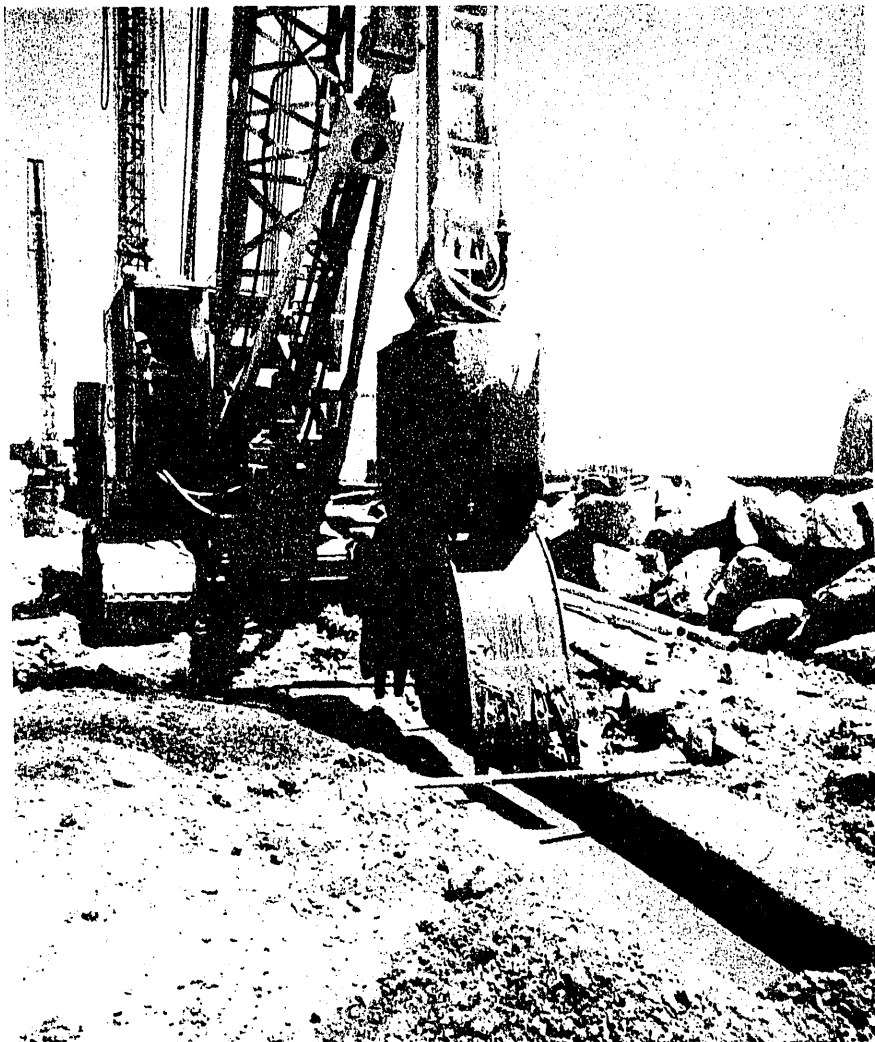
Fig. 6. — Perforación de una pantalla de bentonita-cemento.
