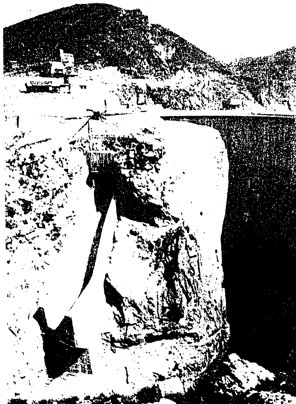
Foto 9. — Vista desde aguas abajo.
