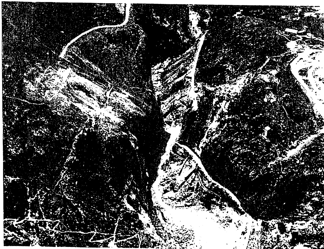
Foto 2.—Vista de la cerrada desde aguas arriba. Se puede observar en la margen derecha la traza del canal aprovechado para el desvío de río.
