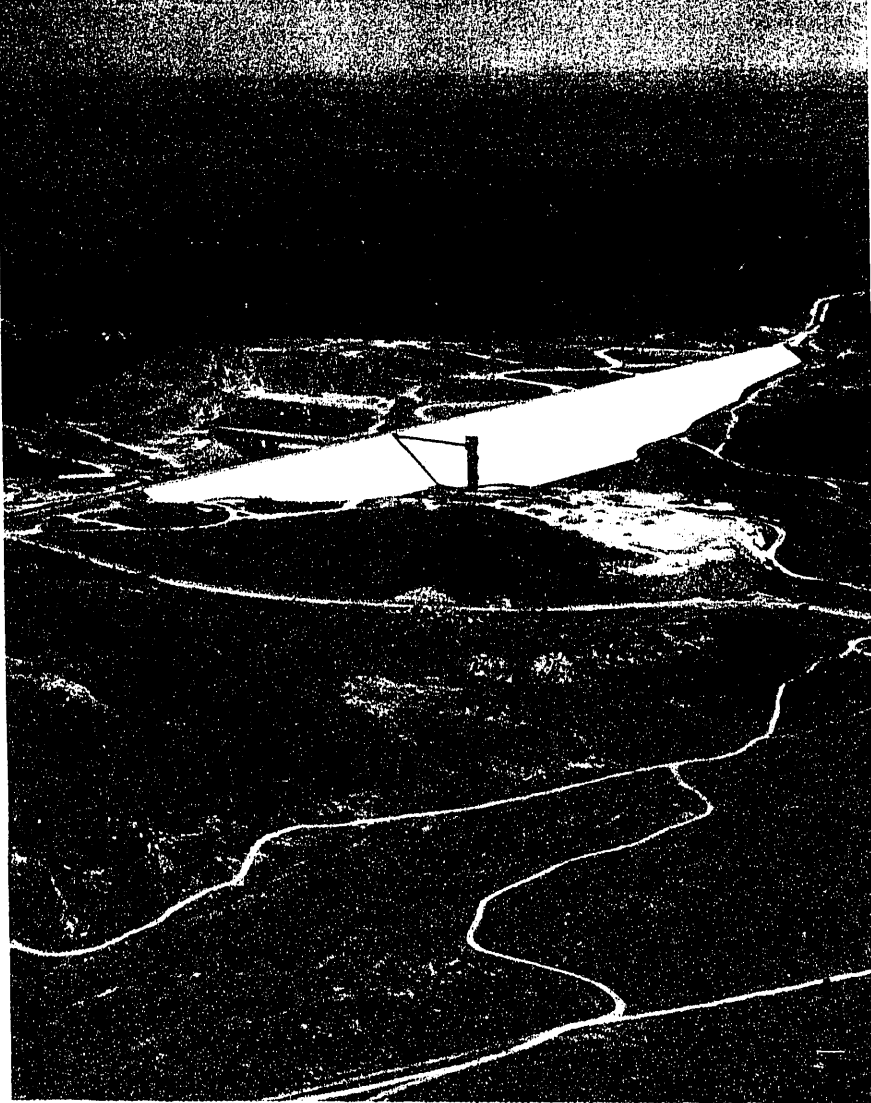
Fig. 3.— Presa de Valmayor vista desde aguas arriba, con la pantalla impermeable y reflectante.
