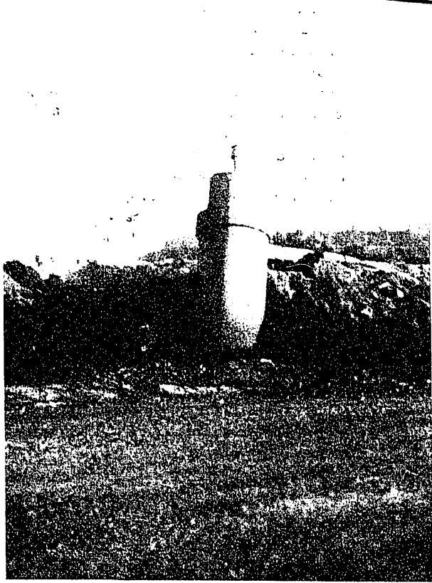
Foto 10. — Tanque de disipación de energía.
