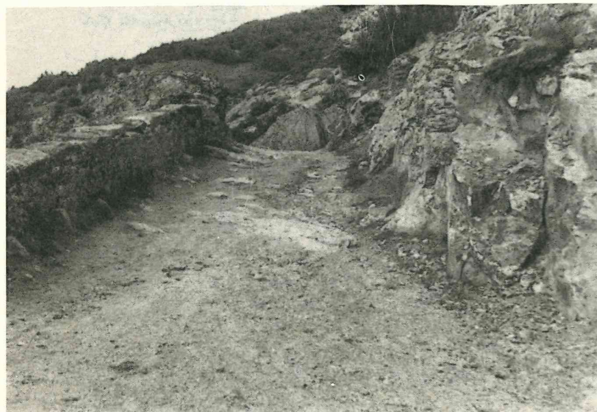
La calzada aguas arriba del puente de Valdepiélago
