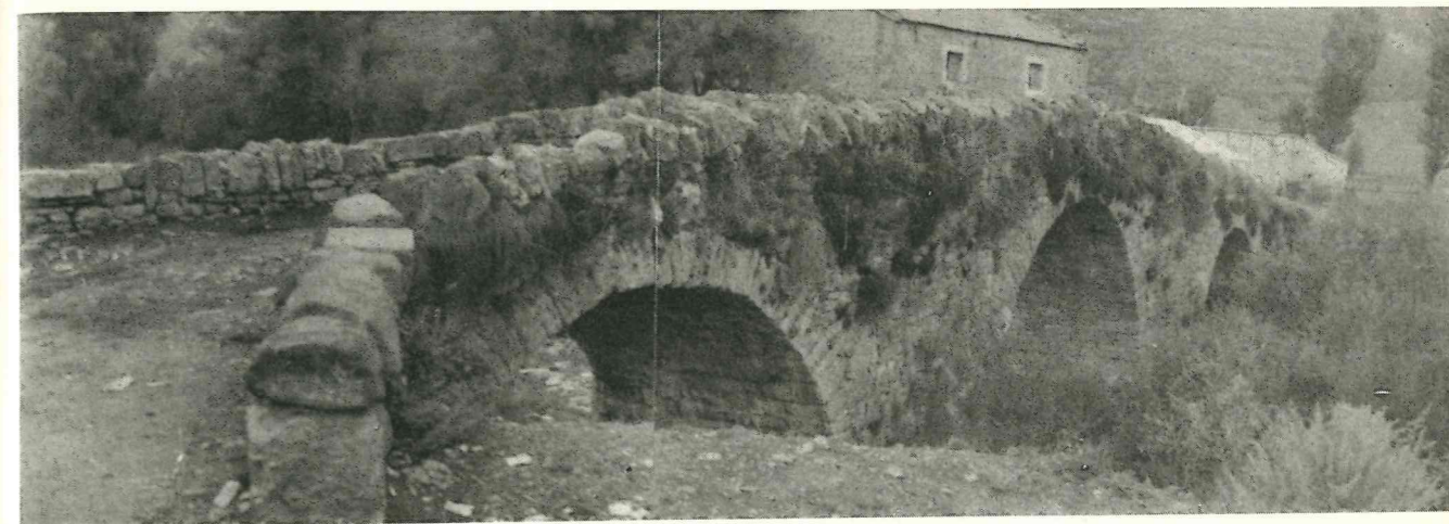
Puente de Valdelugeros
