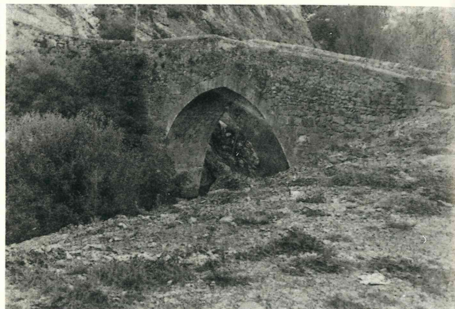
Puente de Valdepiélago
