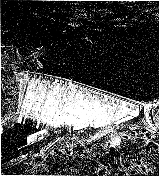
Presa de Iznájar
