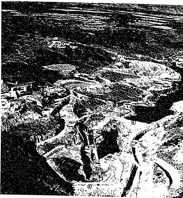
Foto 4.—Vista general del Salto de Granadilla: 1. Poblado de obra; 2. Acceso; 3. Instalaciones auxiliares; 4. Ataguía; 5. Contraataguía; 6. Canal de desvío; 7. Aliviadero; 8. Central. Excavación; 9. Cantera; 10. Puente de Mofrontín.
