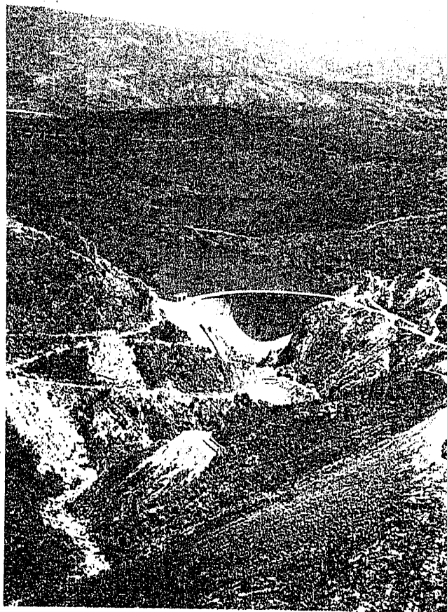
Fig. 1.—Vista general de la presa.
