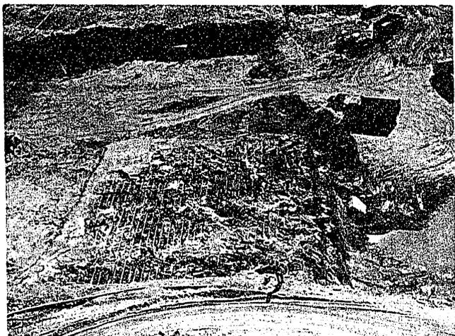
Foto 11.—Presa. Superficie de cimentación del bloque 8.
