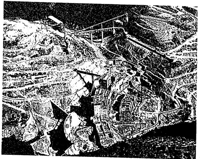
Foto 8.—Vista aérea de las obras: 1. Puente de acceso; 2. Aliviadero del Sever; 3. Aliviadero del Tajo; 4. Central; 5. Ataguías; 6. Contraataguía; 7. Puente sobre el río Sever.
