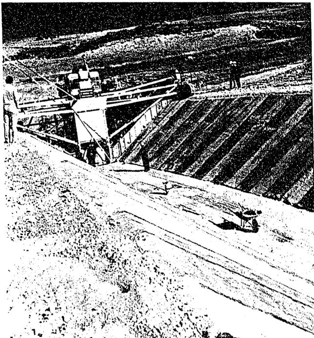
Revestimiento de hormigón empleando la máquina Rahco sobre lámina impermeabilizante tipo Morterplast en el canal de Villarejo.
