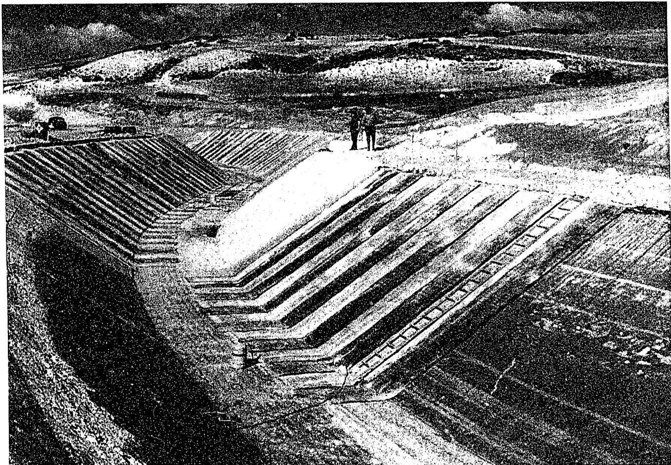
Tramo de colocación experimental con lámina impermeabilizante tipo Morterplast en el canal de Villarejo.
