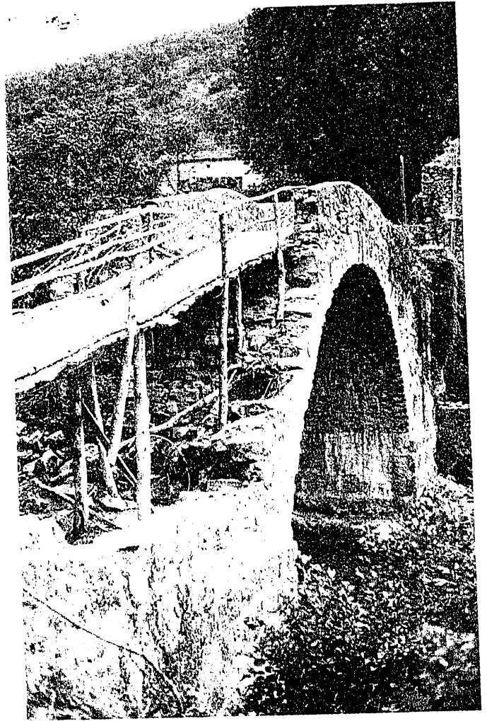
Puente del Salto del Oro, sobre el Calero, en Ramales.
